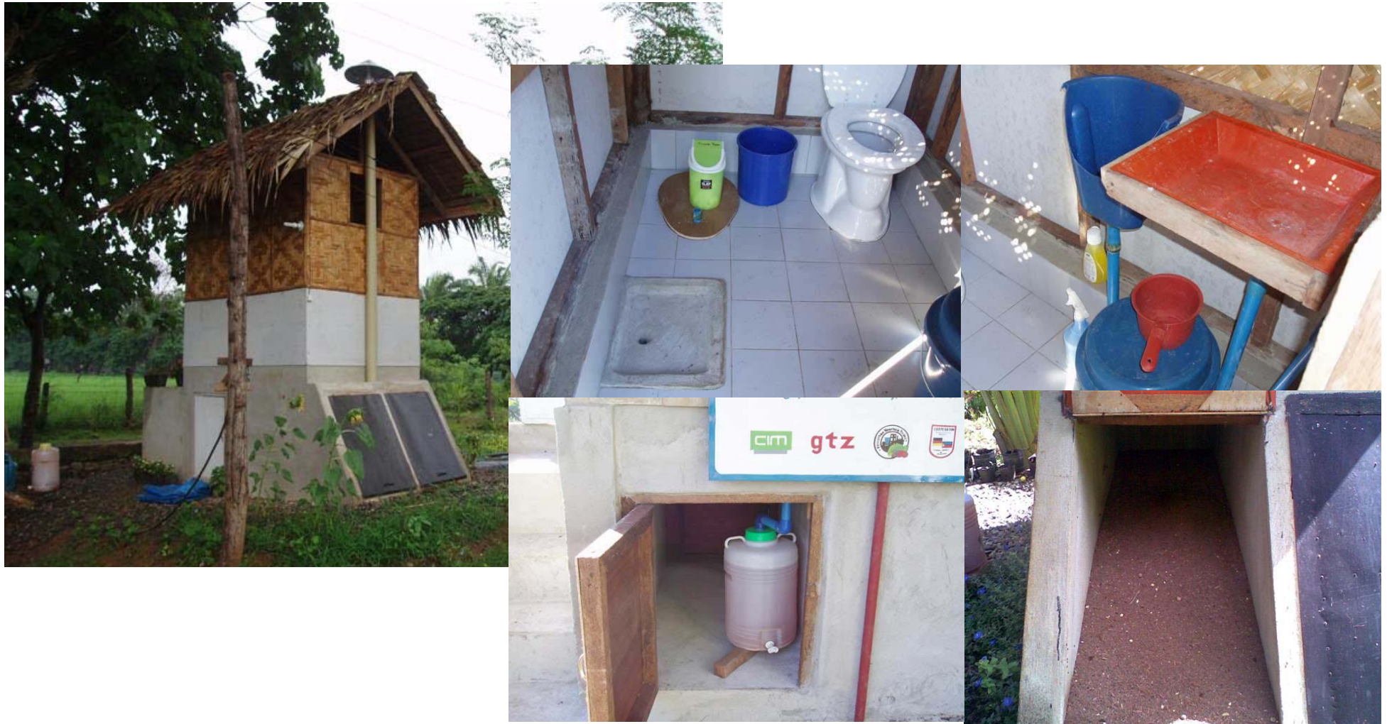
UDDT at PUVeP, Manresa Farm
